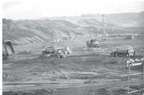
1970年ごろの空港建設の状況。成田国際空港株式会社提供
